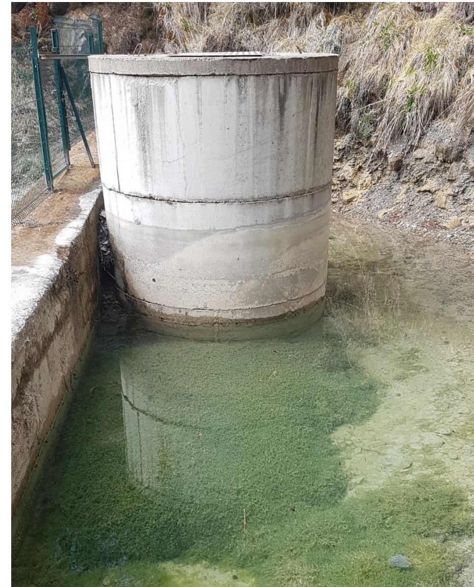
Photographie 16. Captage d'eau superficielle du torrent des Péous
